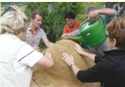
Voller Einsatz beim Bauen eines Brotbackofens aus Lehm
