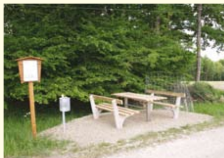
Anlage eines kleinen Rastplatzes am Herrholzer Rundweg in Finklham
